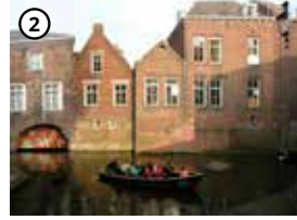
2 DE OUDE APOTHEEK-GEBOUWEN dit complex is ontstaan vanaf 1880 en omvat enkele van de oudste gebouwen op het terrein.
