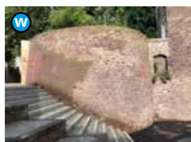
WATERPOORTTOREN De waterpoorttoren uit de 13e eeuw gelegen aan het Herman Moerkerklein is bezig met de restauratie. De waterpoorttoren wordt teruggebracht in de oude hoefijzer-vorm.
