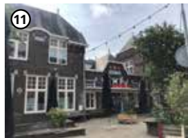
11 HET MARIAPAVILJOEN Dit gebouw werd in 1915 opgetrokken voor de behandeling van personen die leden aan besmettelijke ziekten.
