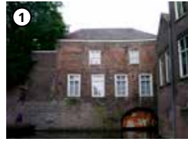
1 HET REGENTENHUIS Het regentenhuis is het oudste nog bestaande gebouw van de hele site en is afkomstig uit de 16e eeuw.
